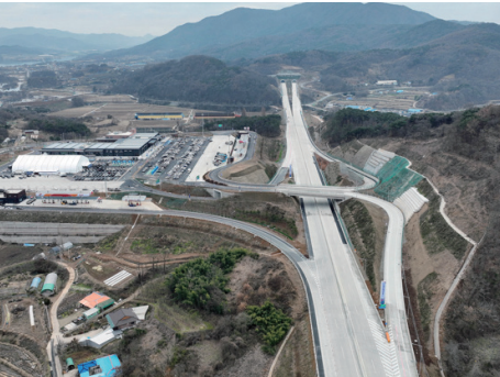
평택~부여(서부내륙) 고속도로 봉수산터널 기계설비
