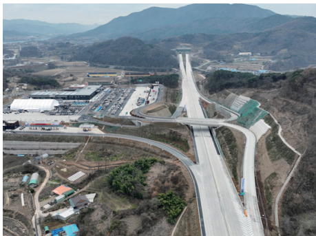
평택~부여(서부내륙) 고속도로 봉수산터널 기계설비
